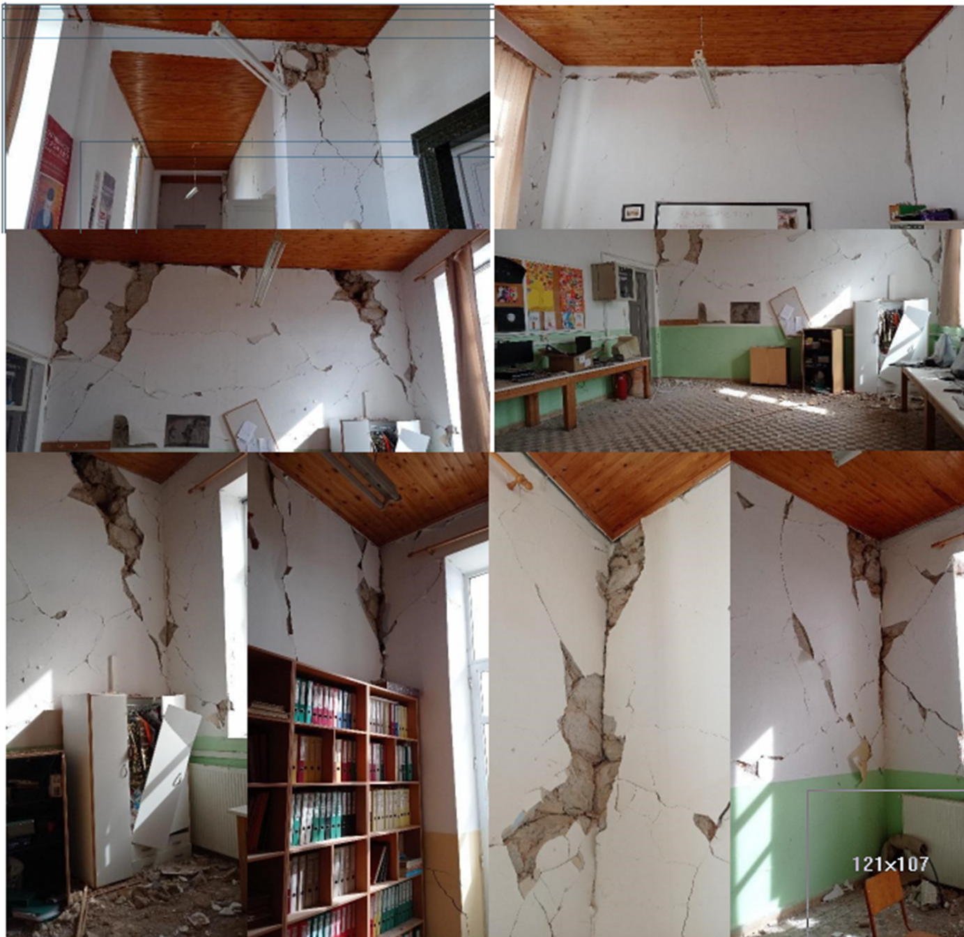
Δημοτικό Σχολείο Αρκαλοχωρίου. κτίριο φέρουσας τοιχοποιίας
